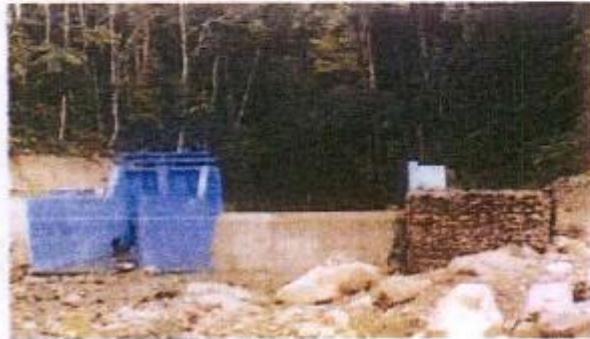
Fotografía con concreto reforzado (sistema muros estructurales)
