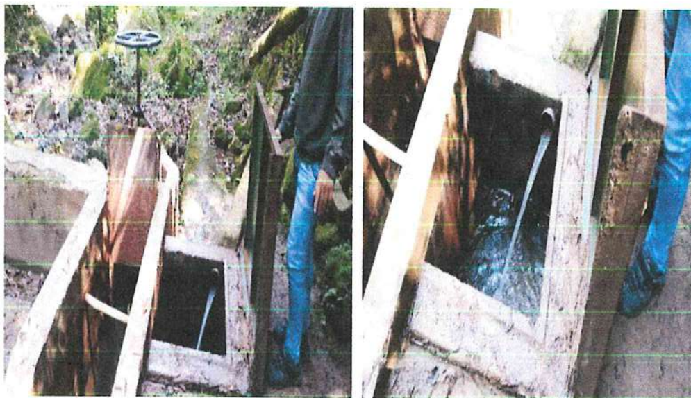
Fuente de la vertiente 1, y estructura de captación
