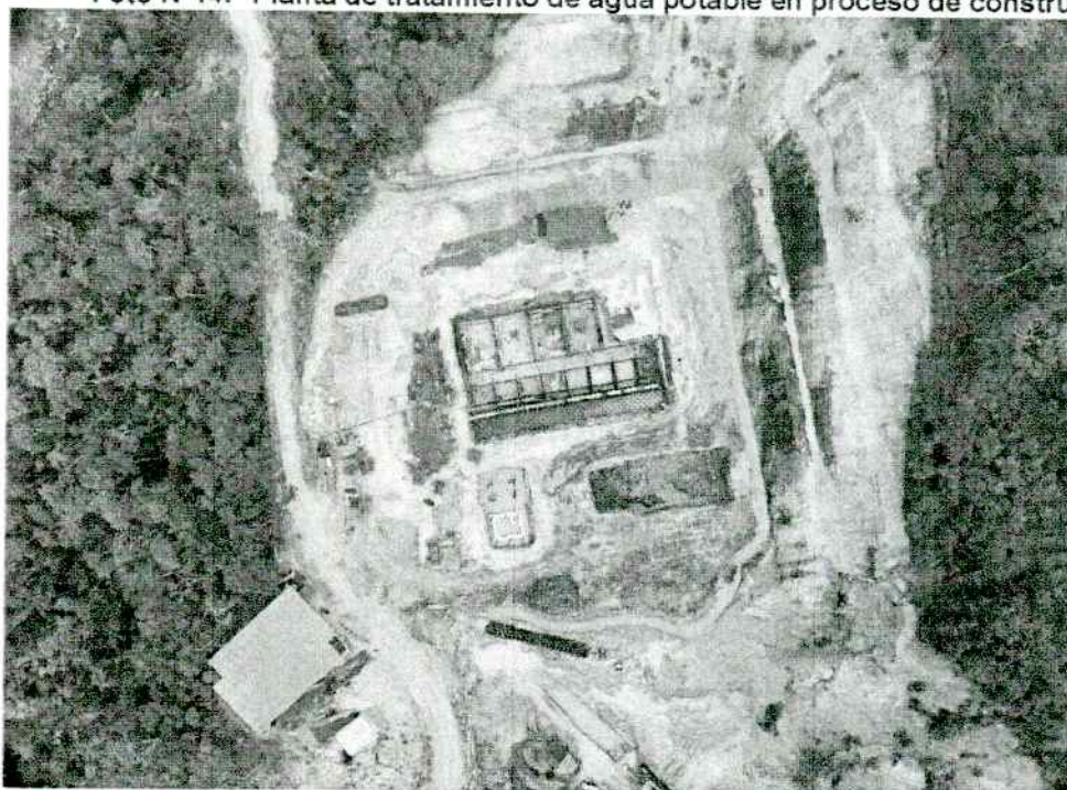
Foto N°14: Planta de tratamiento de agua potable en proceso de construcción
