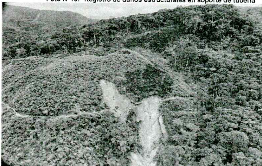
Foto N°15: Registro de daños estructurales en soporte de tubería
