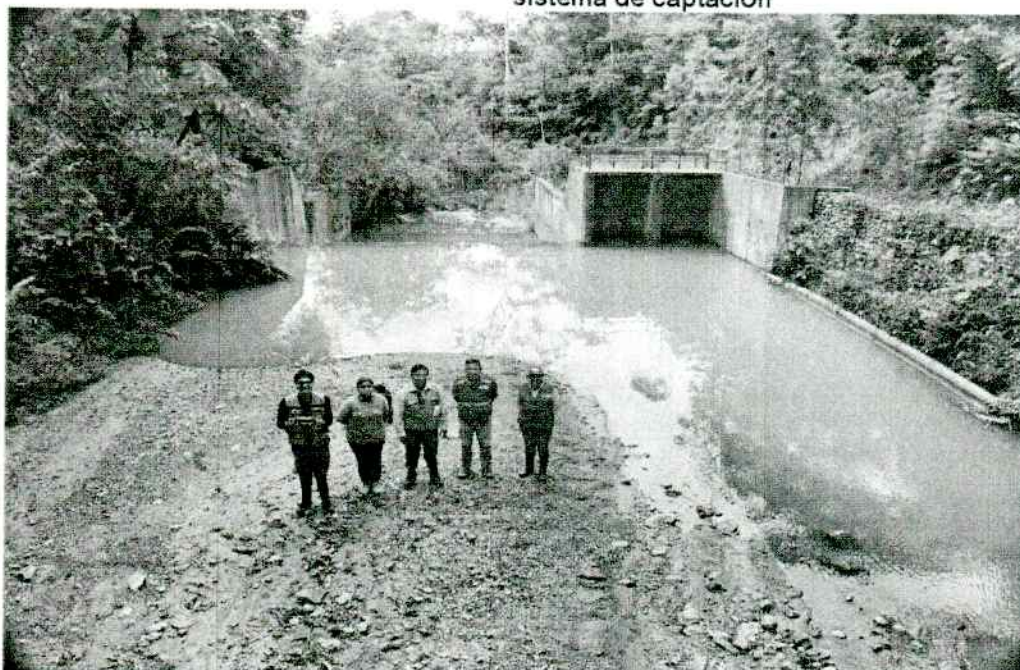
Foto N°26: Zona de acceso y mantenimiento de infraestructura hidráulica del sistema de captación
