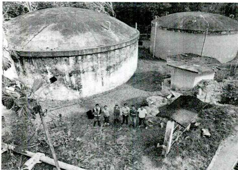
Foto N°28: Vista general de la zona de intervención
