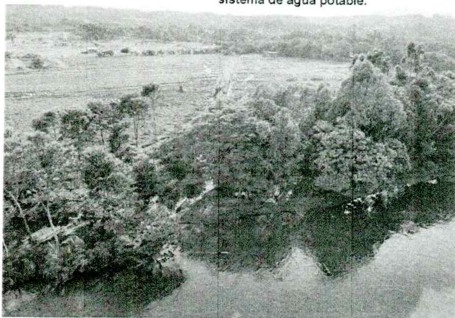
Foto N°30: Vista panorámica de la zona de captación y entorno natural del sistema de agua potable.
