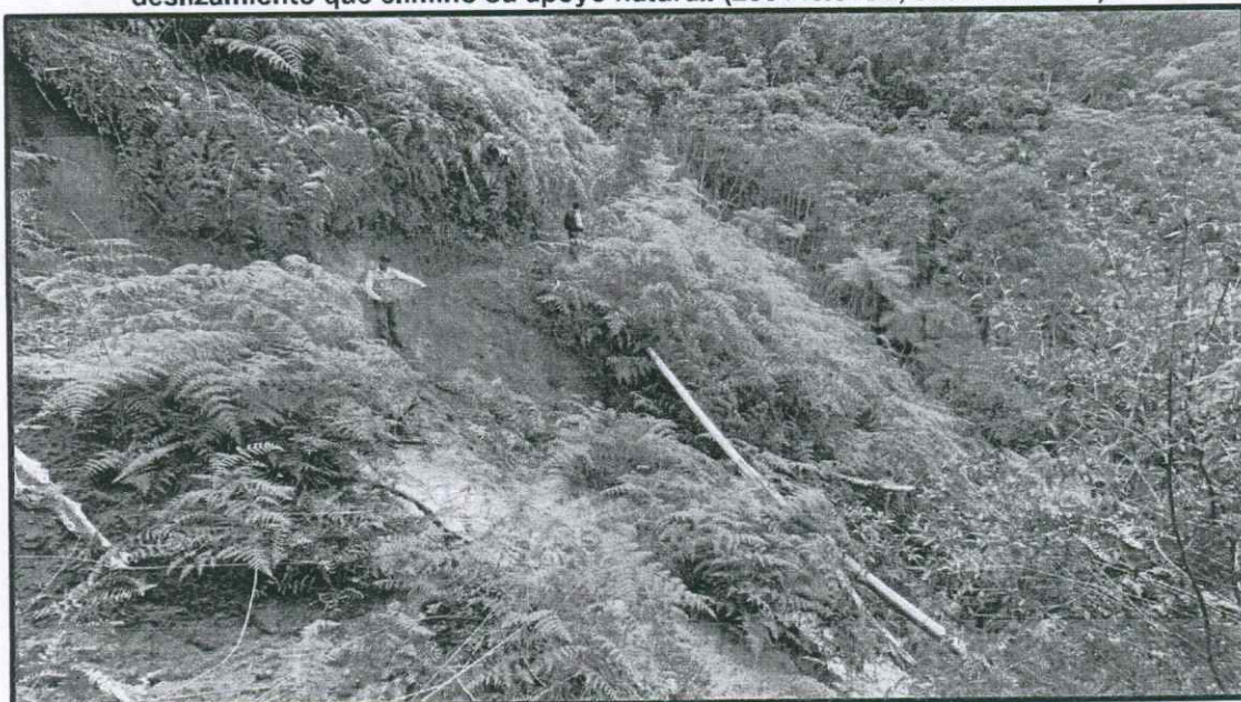
Foto N°7: Tramo de la tubería de conducción de la captación Chuyayacu afectado por deslizamiento que eliminó su apoyo natural. (290140.310E, 9333789.950N)
