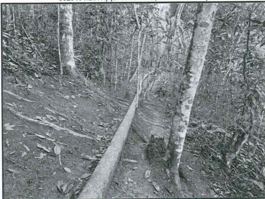
Foto N°2: Tubería de conducción expuesta debido a la erosión del suelo (279875.309E, 9329191.287N) (279855.343E, 9329001.400N)
