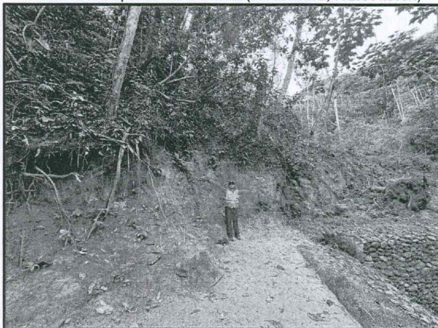
Foto N°9: Talud adyacente a la captación que requiere obras de protección contra deslizamientos por lluvias intensas. (279821.520E, 9328964.665N)
