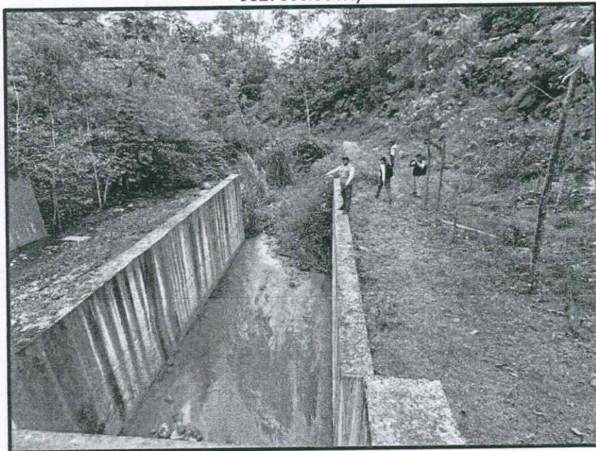
Foto N°4: Obstrucción parcial del canal de limpia de la captación Rumiyacu (282817.197N, 9327666.356N)
