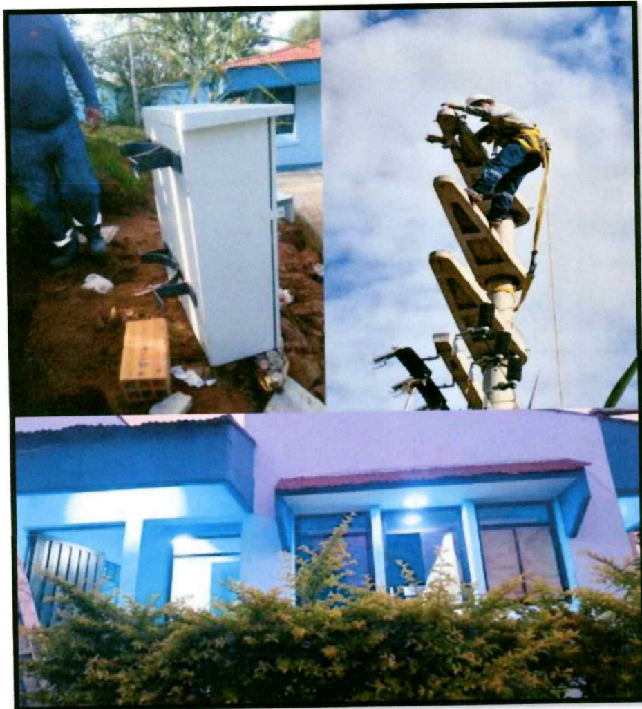
En la imagen es el mejoramiento de las redes primarias y secundarias de la PTAP San Mateo.
